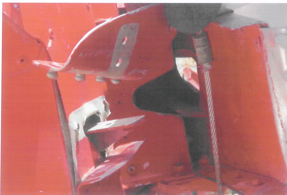
Φωτ. 9: Αποσπασμένο υποστήριγμα (Bracket) του "Elevator" κάτω επιφανείας
