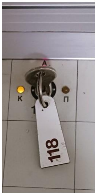
Εικόνα 46. Λεπτομέρεια του κλειδιού τριών θέσεων για το χειρισμό των αλλαγών 118 στον Πίνακα Ελέγχου Λάρισας.
