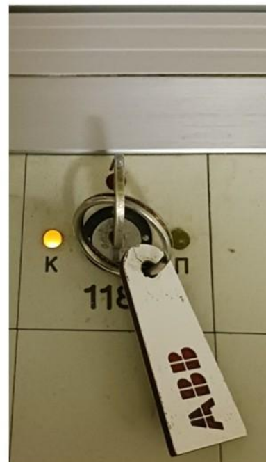
Εικόνα 46. Λεπτομέρεια του κλειδιού τριών θέσεων για το χειρισμό των αλλαγών 118 στον Πίνακα Ελέγχου Λάρισας.
