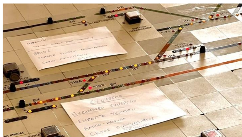
Εικόνα 48. Λεπτομέρεια του Πίνακα Ελέγχου Λάρισας με χαραγμένη διαδρομή για τη διέλευση μιας αλλαγής στην παρακαμπτήριο.
